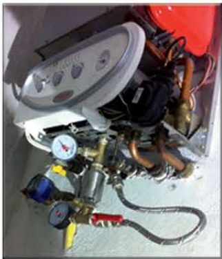
Die Installation auf Heizkessel
